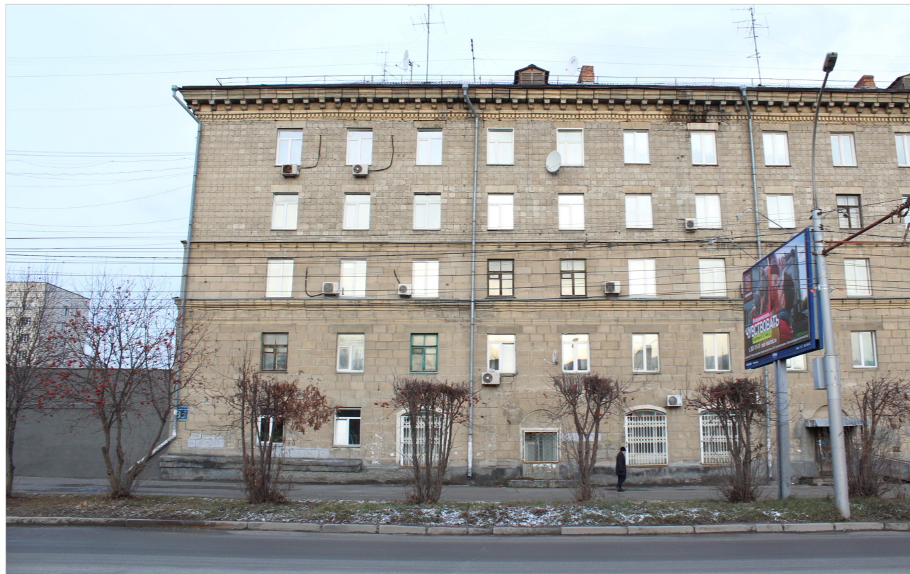
Главный фасад 1-5, выходящий на проспект Карла Маркса
